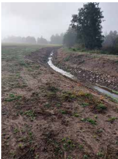
Fiskväg som nu förbinder Lilla Torpsbäcken med Torpsbäcken och tillgängliggör gäddvåtmarker.
